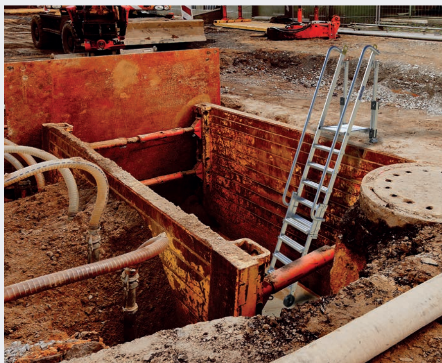
Montants télescopiques pour mise de niveau
