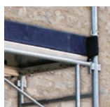
Réglage plancher tous les 1,00 m
