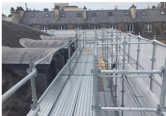
Les structures M368 sont ainsi particulièrement recommandées pour les travaux de réfection des monuments historiques. 40 tonnes de matériel ont été nécessaires pour la réalisation de ce chantier.
